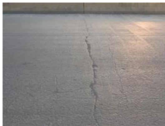
墩顶桥面开裂
