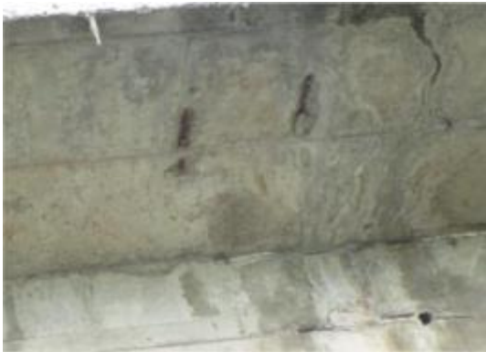
梁板锈胀露筋
