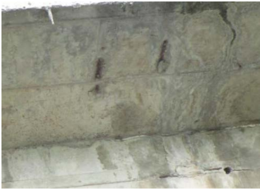
梁板锈胀露筋
