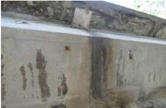
空心板锈胀露筋
