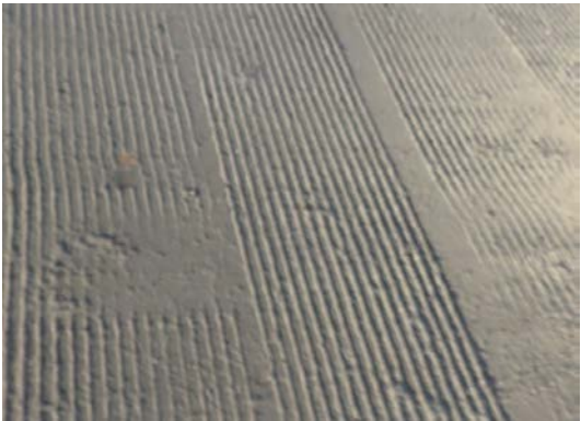
桥面磨损露骨
