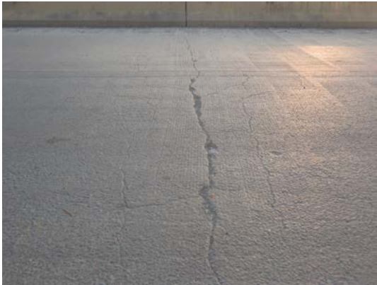
墩顶桥面开裂
