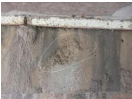
桥台混凝土破损
