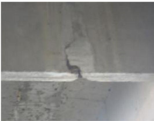
T 梁横隔板破损
