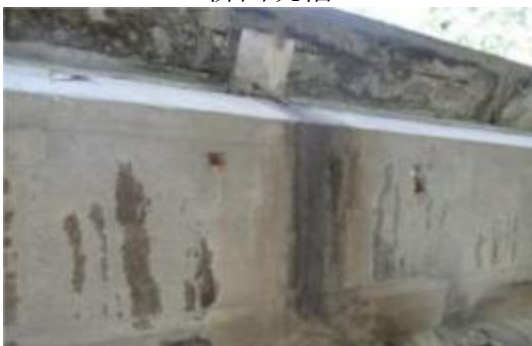
空心板锈胀露筋
