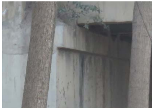
桥台破损、渗水
