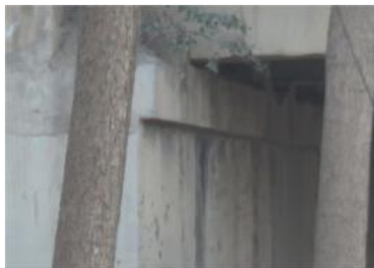
桥台破损、渗水
