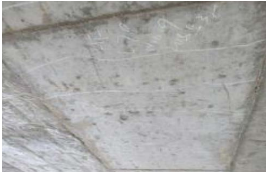
空心板裂缝
