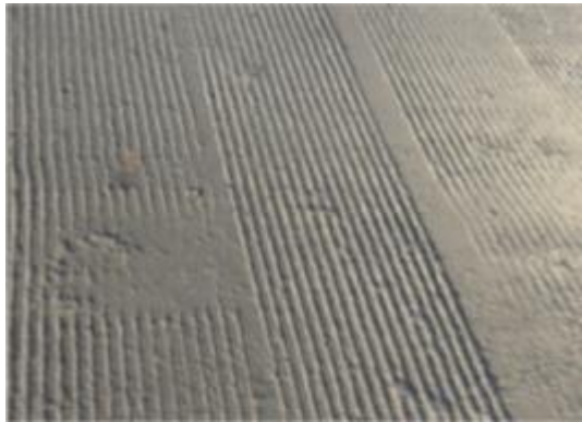
桥面磨损露骨
