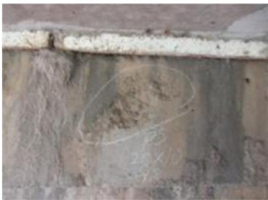
桥台混凝土破损
