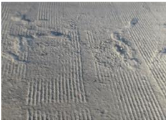
桥面开裂坑槽
