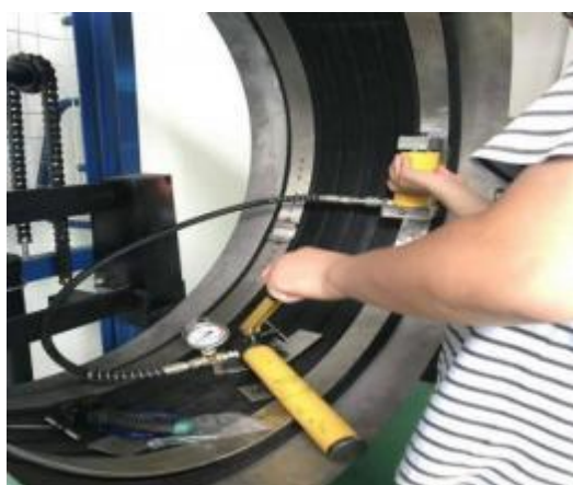
不锈钢双胀环原材料及施工示意图
