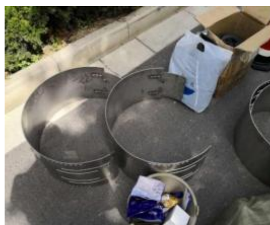
不锈钢双胀环原材料及施工示意图
