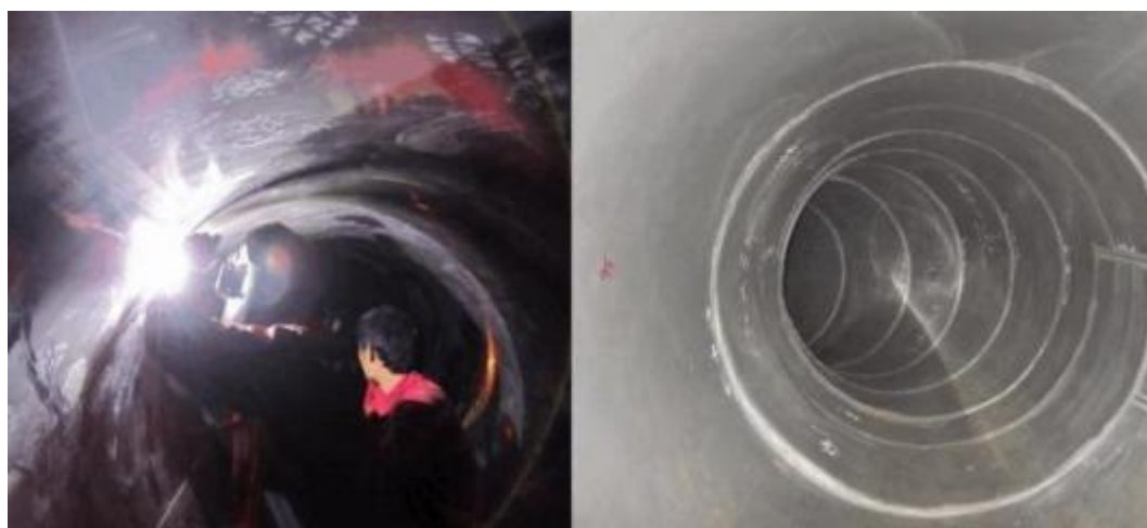
不锈钢套筒修复工艺示意图
