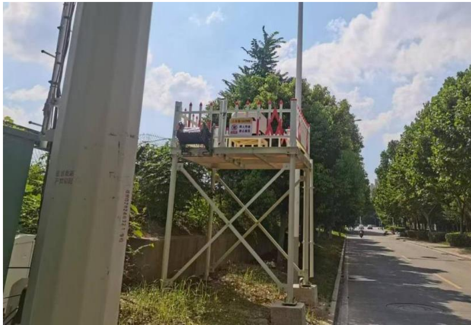
图 5.17 铁塔无人机起降场地建设示例
