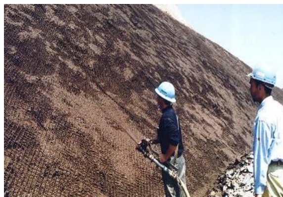
1、边坡开挖后，坡面挂三维土工网施工 2、挂网结束后坡面喷施客土及草籽等
