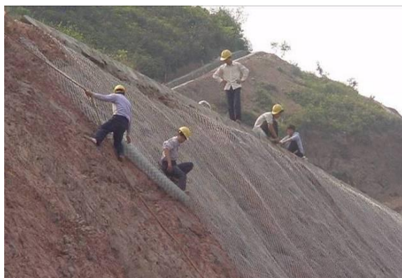
1、边坡开挖后，坡面挂三维土工网施工 2、挂网结束后坡面喷施客土及草籽等
