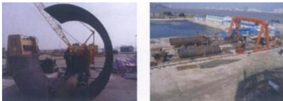
图 6.3.1.4-1 钢管现场制作实例
