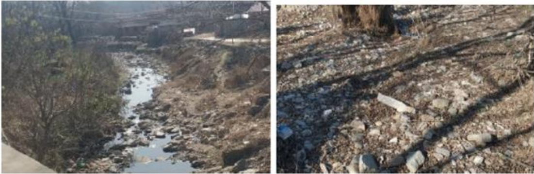
图 14.3-3 西十里河河道淤积砂石现状
