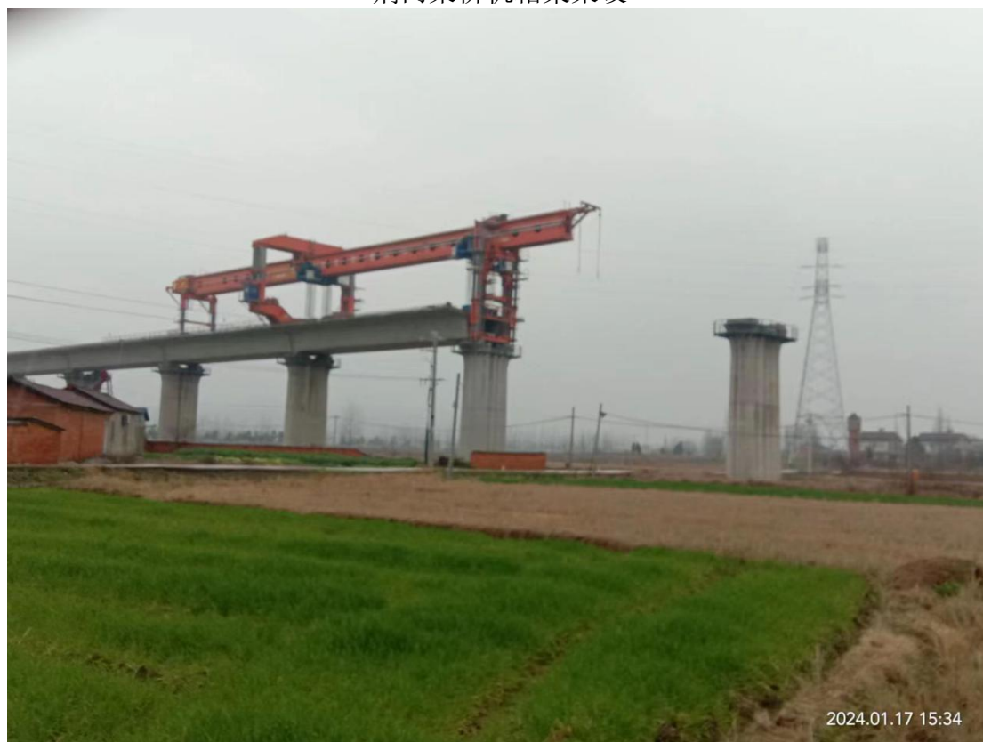
当阳架桥机箱梁架设
