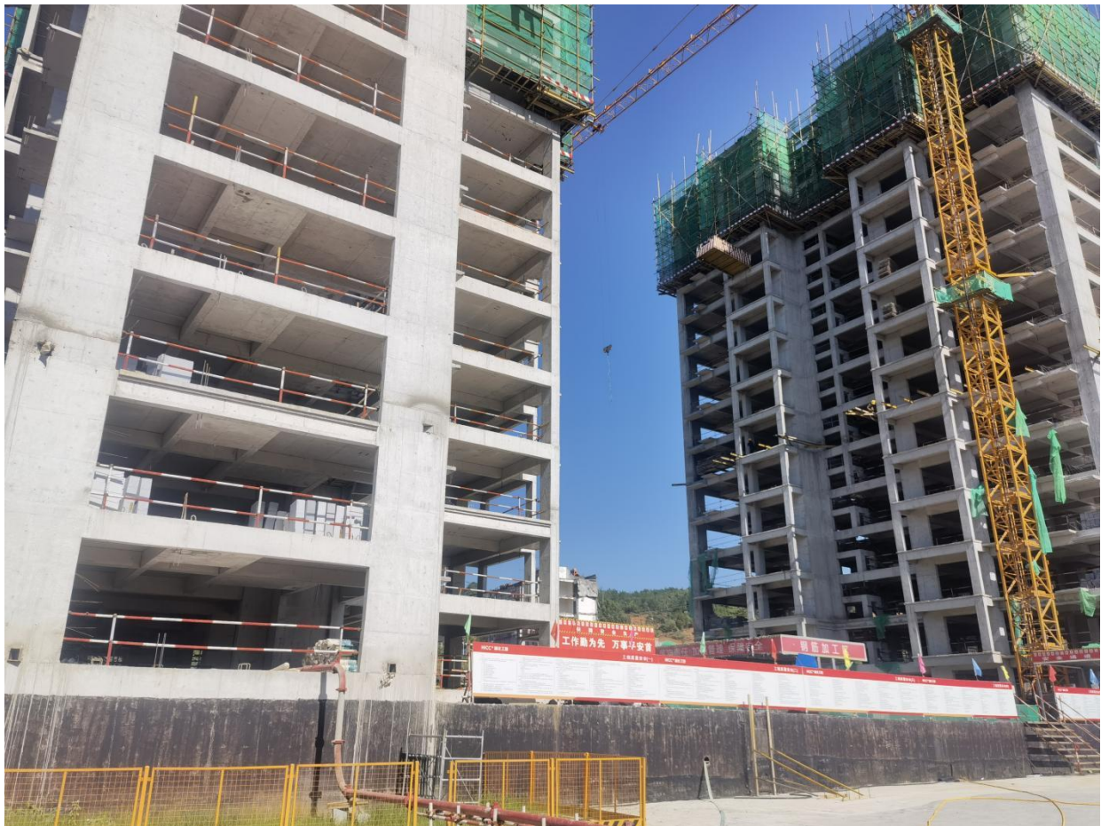
余家湾项目现场施工图
