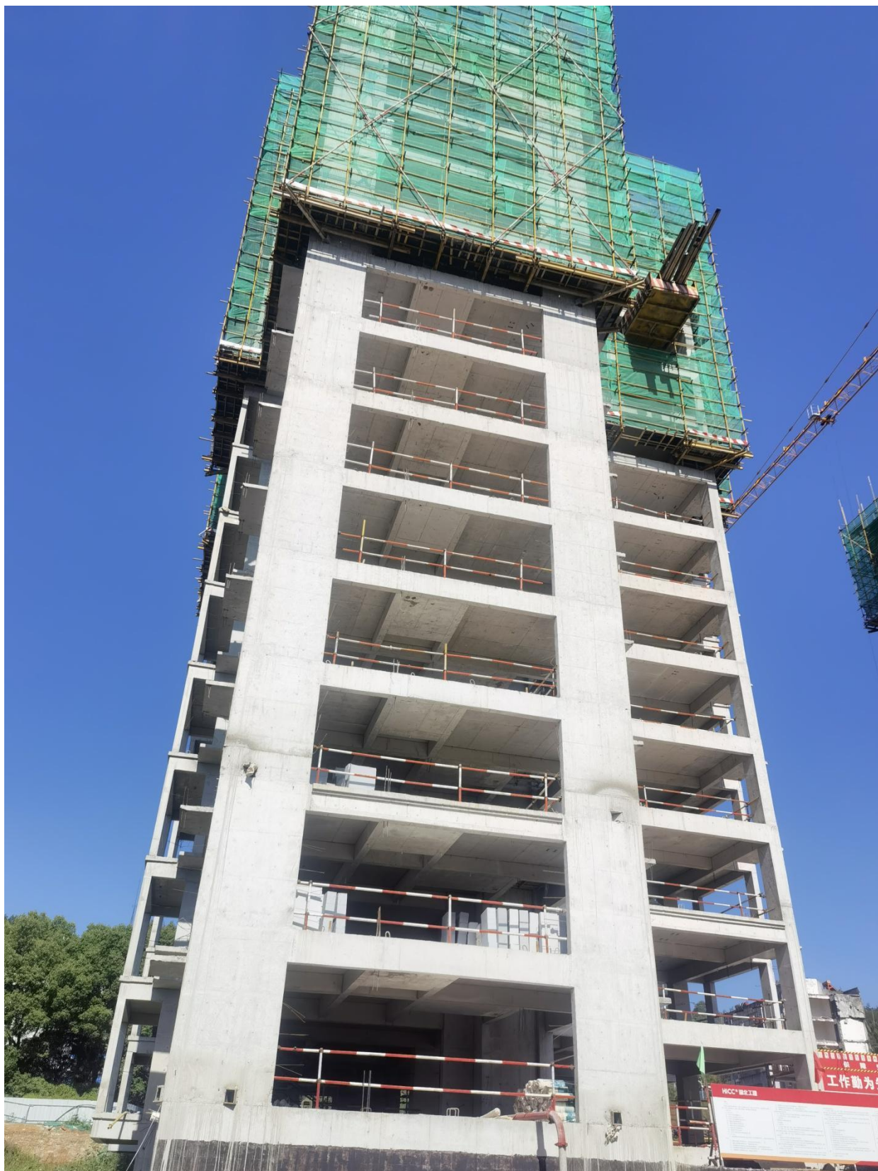
余家湾项目现场施工图
