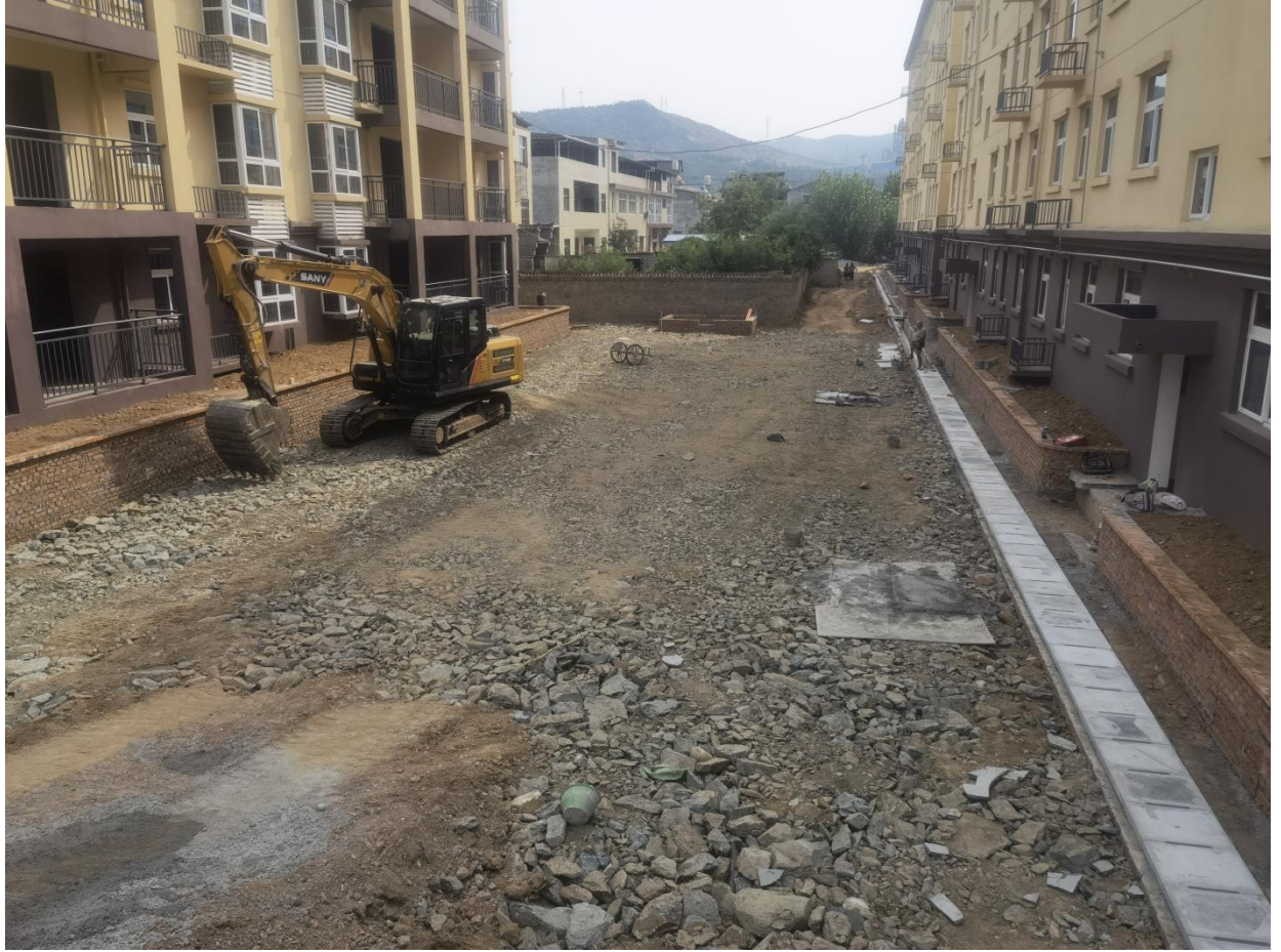
土门安置小区现场施工图
