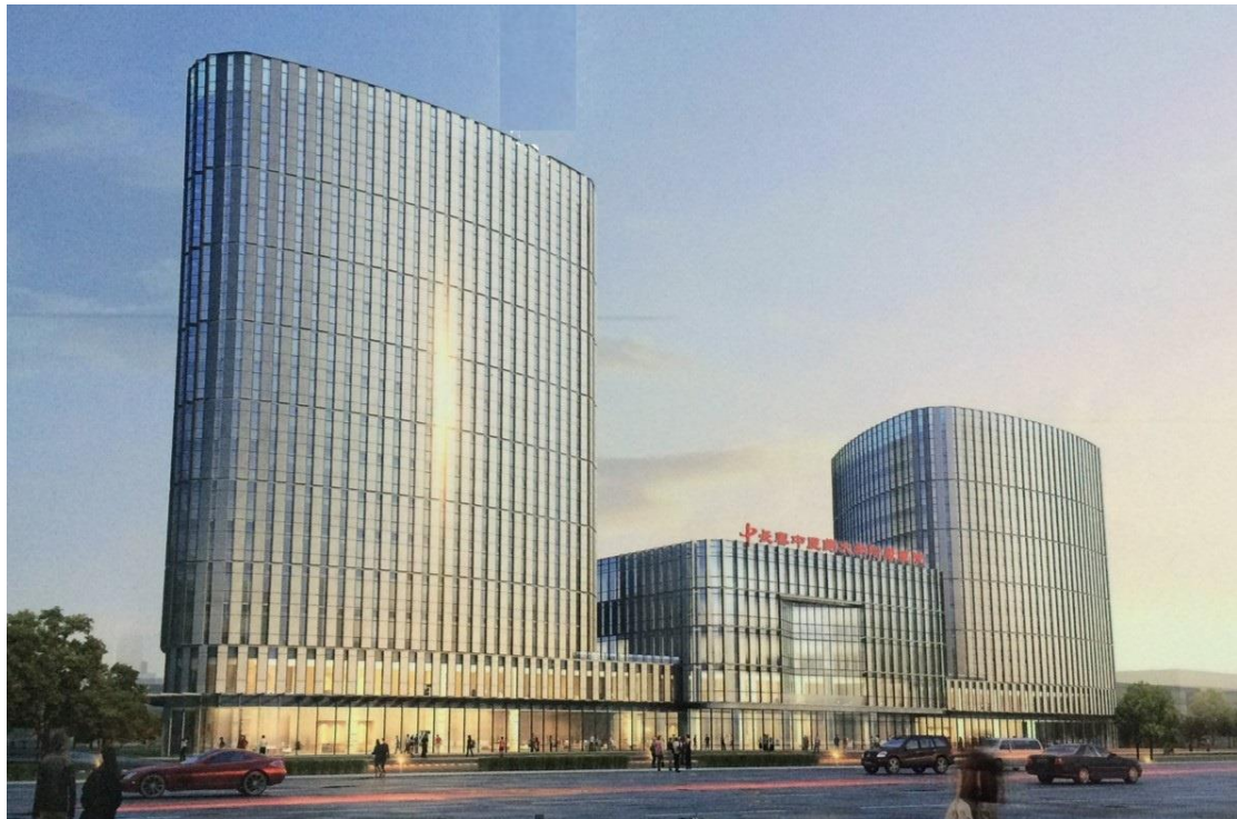
长春中医药大学附属第三临床医院建设项目效果示意图
